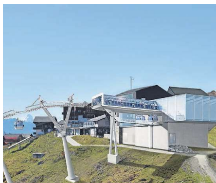
Im Bau, Bergstation der neuen 10er-Gondelbahn auf die Fiescheralp.
